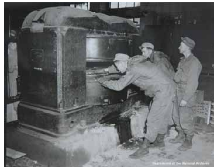
阪大サイクロトロン破壊撤去(1945.11.24) (米国国立公文書館所蔵)
